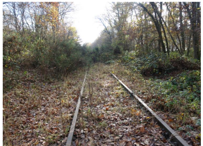
État de la voie Dreux-Chartres lors de la reconnaissance- Ph Emilienne Lardy
